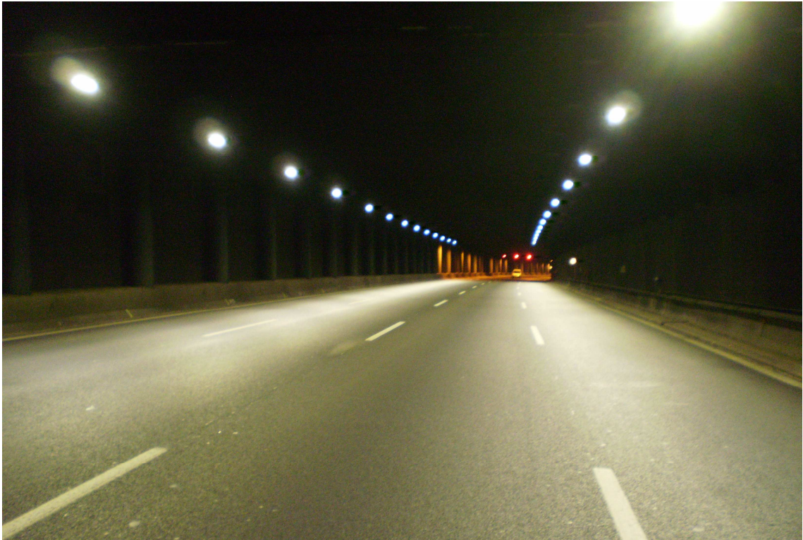
Fotografía 7. Túnel de las calzadas superpuestas M-40. Iluminación con LED. (sentido de la marcha). Luminancia media 3 cd/m 2 .
