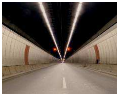
Figura 3.1. Túnel iluminado con lámparas fluorescentes.
