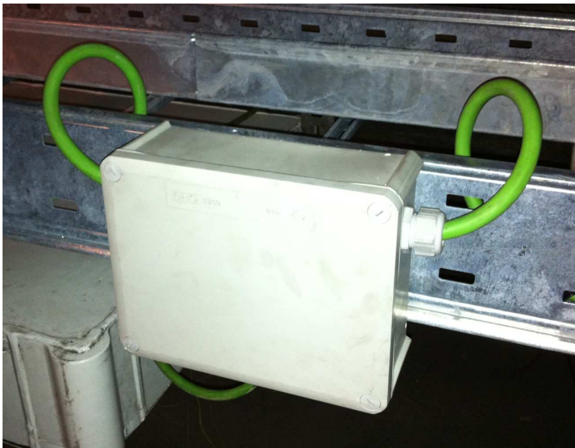
Figura 3.8. Cajas estancas para colocar bornas.
