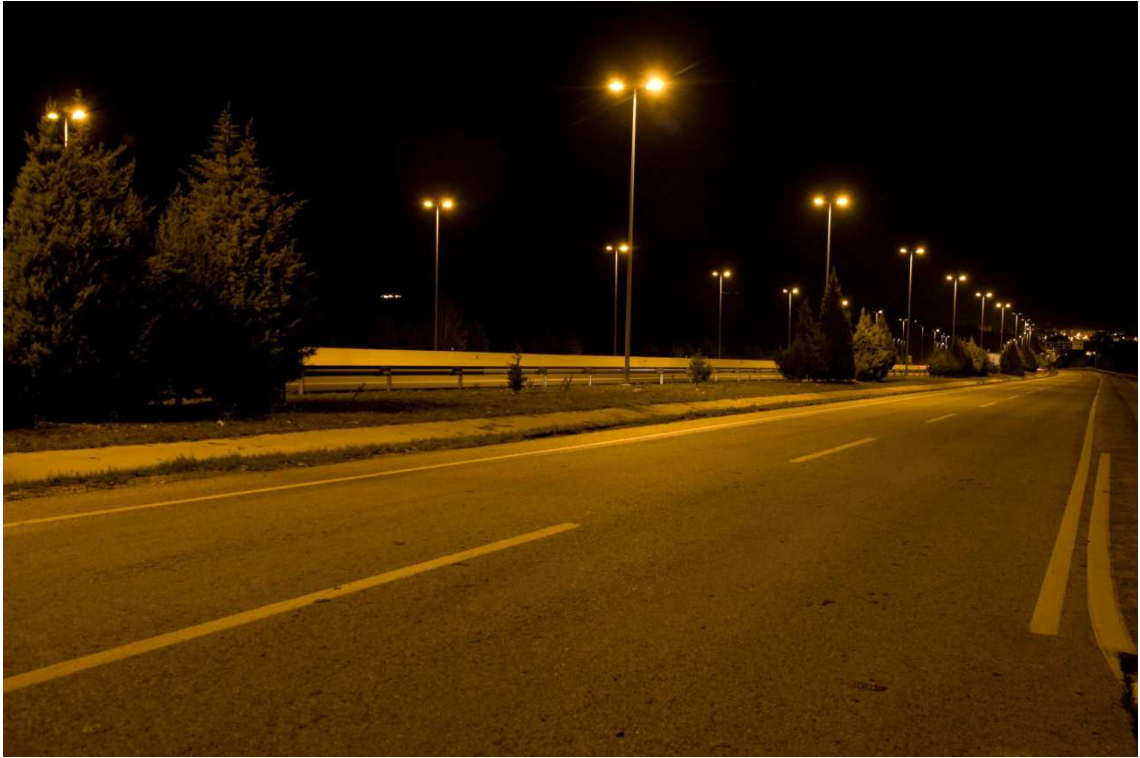
Fotografía 7. Autovía A-2. Sección tipo con dos calzadas y dos carriles cada una. Iluminación con tecnología VSAP. Tipo de implantación: axial.
