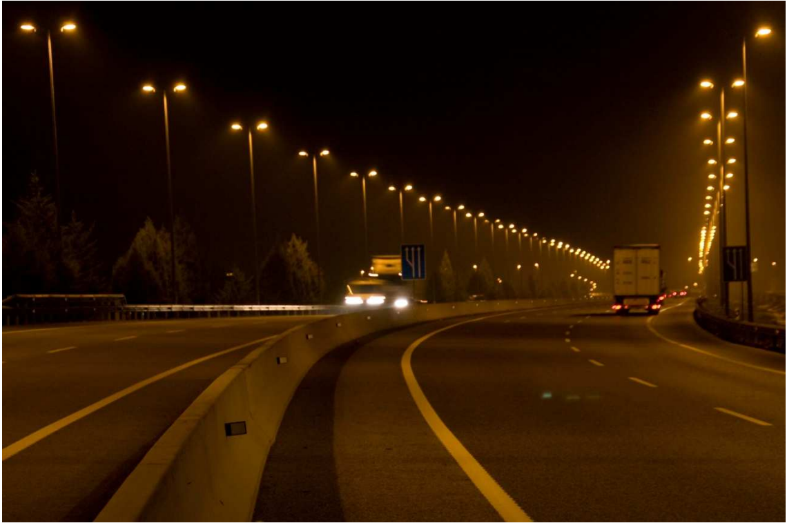
Fotografía 9. Autovía A-2. Sección tipo con dos calzadas y dos carriles cada una. Iluminación con tecnología VSAP. Tipo de implantación: axial.
