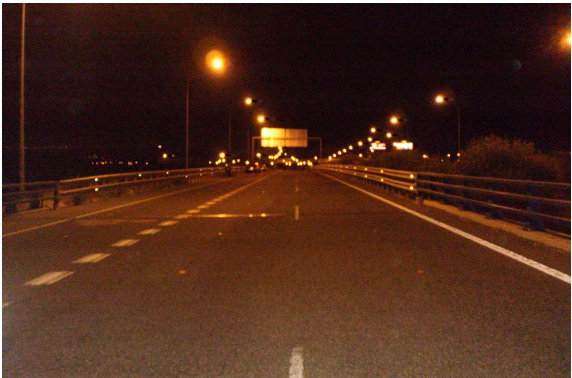
Fotografía 2. Autovía M-13. Sección tipo con dos calzadas y tres carriles cada una. Iluminación con tecnología VSAP con báculos de 14 m de altura. Interdistancia 40 m. Tipo de implantación: tresbolillo.
