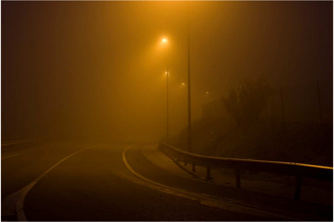
Fotografía 5. Sección tipo con una calzada y un carril por sentido. Iluminación con tecnología VSAP. Tipo de implantación: unilateral.
