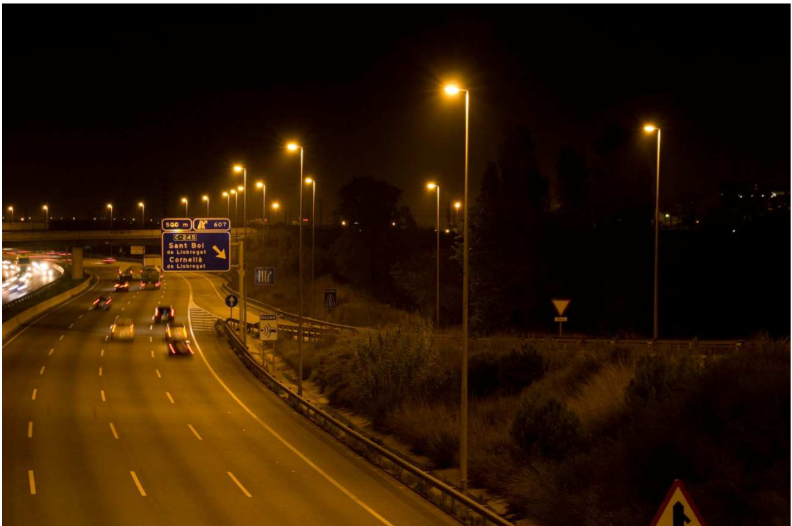
Fotografía 4. Autovía A-2. Sección tipo con dos calzadas y cuatro carriles cada una. Iluminación con tecnología VSAP. Interdistancia 40 m. Tipo de implantación: axial.
